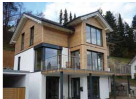
Gerade in Passiv- und Niedrigenergiehäusern, deren Gebäudehülle besonders dicht gebaut ist, muss für einen regelmäßigen Luftaustausch gesorgt werden.
