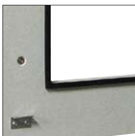
Brand- und Rauchschutz- dichtung umlaufend
